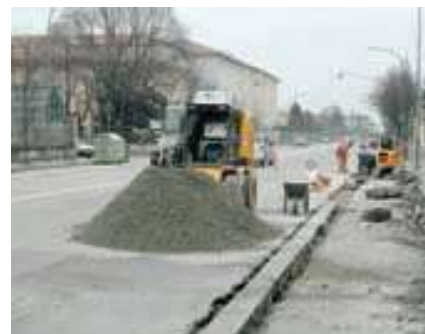
Situazione non regolare – manca la recinzione di delimitazione
