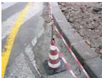
Situazione non regolare, il ferro sporgente dal cono non è protetto
